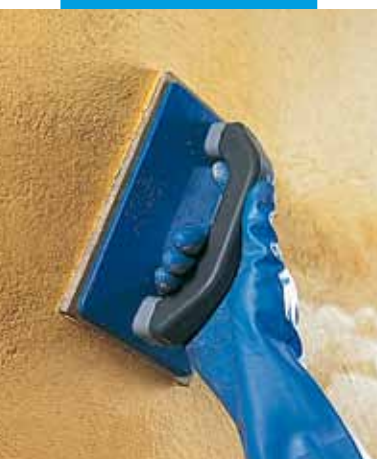
Выравнивание Silexcolor Tonachino теркой с губчатым покрытием
